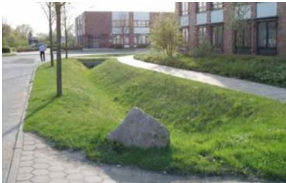
Kuva 6.4. Esimerkkikuva viherpeitteisestä ojasta. Lähde: Hulevesiopus 2012.
