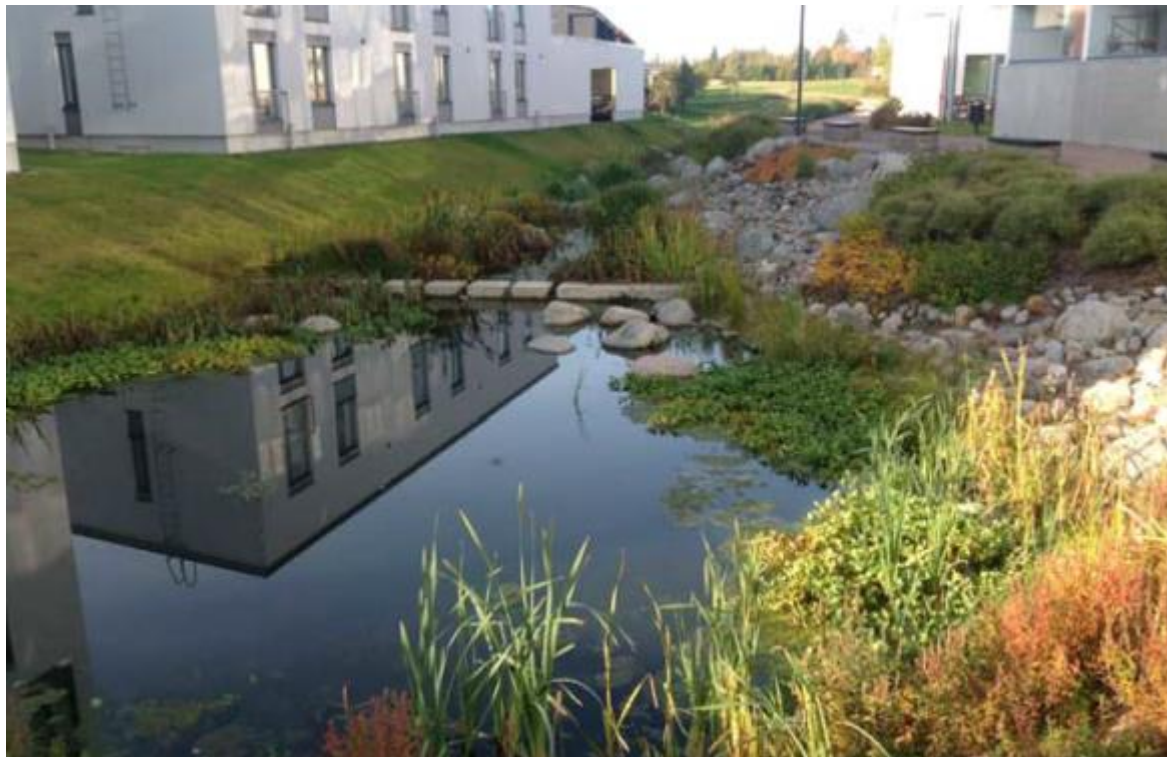
Kuva 6.6. Biosuodattava hulevesipainanne/kosteikko voi olla osan aikaa vuodesta kuivana, joten kasvit on valittava sen mukaisesti, että ne kestävät vesipinnan vaihteluita. Kuva: Vantaanjoen ja Helsingin seudun vesiensuojeluyhdistys ry.
