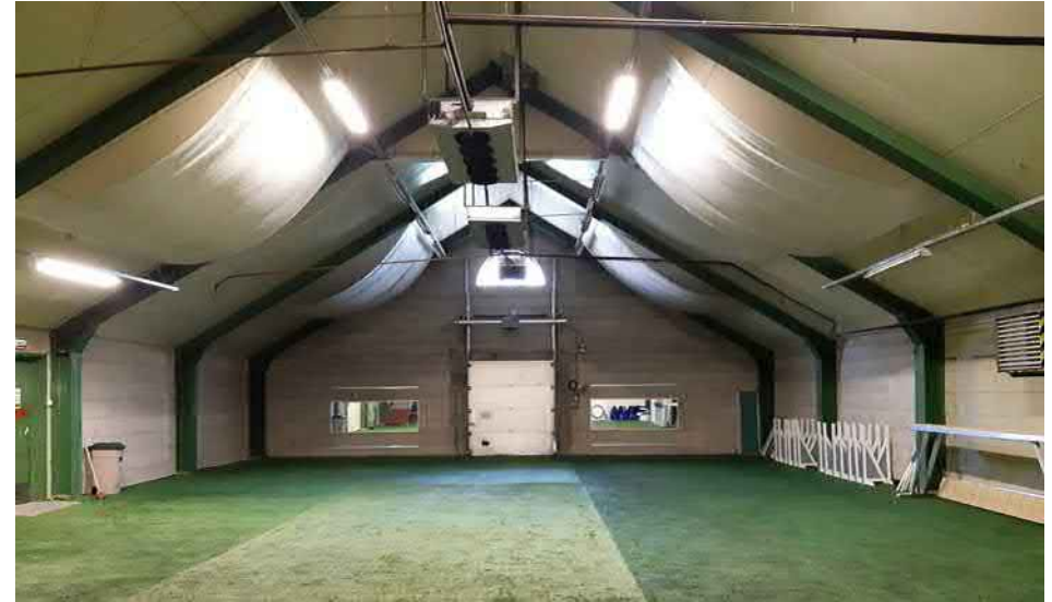
Kuva 61. Entinen juustovarasto on muutettu Koiraharrastustilaksi. Tilassa on teräksiset, vihreäksi maalatut pilarit ja palkit. Päädyssä on puolipyöreä ikkuna.
