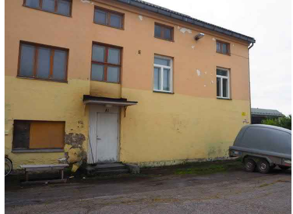
Kuva 47. Vanhassa meijerirakennuksessa on myös asunto, jonka sisäänkäynti on katoslipalla katettu. Oven oikealla puolella on aiemmin ollut kaksi isoa oviaukkoa.
