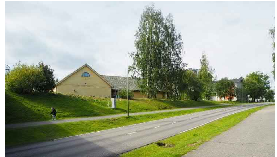
Kuva 36. Osuusmeijerin harkkorakenteinen pääty rautatiealikulun suunnasta Kauppakadun varresta.
