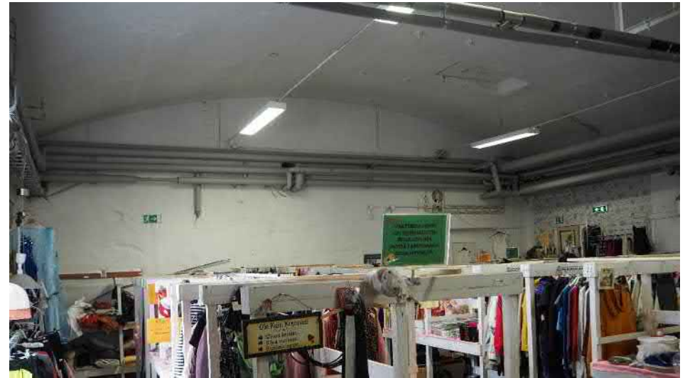
Kuva 62. Vanhassa meijerisalissa on hieno kaareva betoniholvikatto. Tehdyt väliseinämuutokset katkaisevat osittain kaarevan katon näkymisen.
