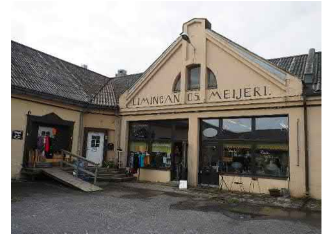
Kuva 68. Maidonvastaanottotilan ja meijerisalin kohdalla vanhat ovi- ja ikkuna-aukot on korvattu lasiseinillä.
