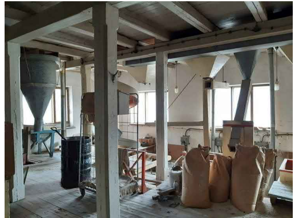
Kuva 56. Myllyn ullakkoa elokuussa 2021. Tila on valoisa ja väritykseltään myös vaalea. Tiiliseinät on rapattu ja maalattu valkoiseksi. Tilassa on sirot vaaleat puupilarit -ja palkit, joissa on myös kaunista detaljointia. Mylly ei ole muussa käytössä kuin varastona ja on kylmillään. Sen alkuperäinen asu on säilynyt.
