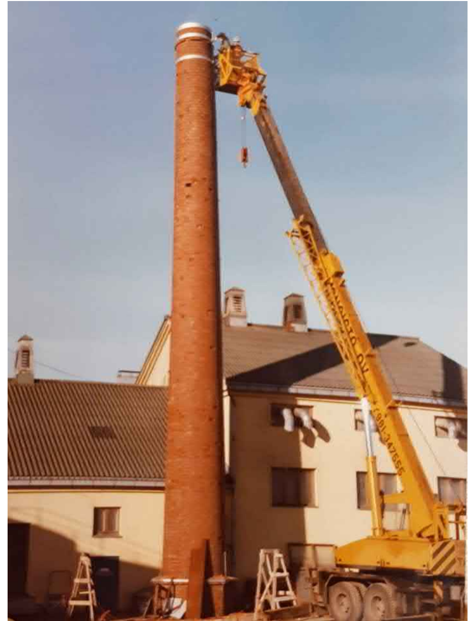
Kuva 32. Meijerin piipun purkutöiden alku. Postikortti aiheesta on vuoden 1980 heinäkuulta. Piippu oli punatiilillä verhoiltu. (Limingan Osuusmeijerin arkisto)
