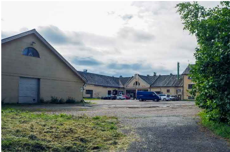
Kuva 35. Osuusmeijerin pihaa Kauppakadun varresta katsottuna. Vasemmalla 1980-luvulla rakennettu harkkorakenteinen laajennus, jossa toimii koira-areena. Kauempana juustola ja meijerisali ja mylly. Meijerisalissa toimii nykyisin kirpputori.
