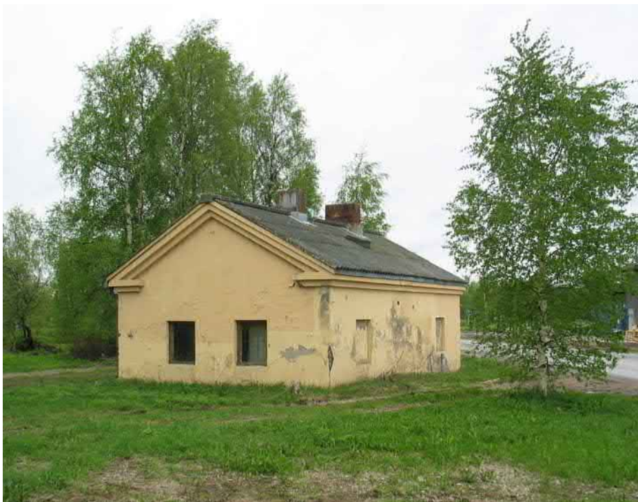
Kuva 24. Tontilta purettu vuonna 1938 valmistunut klassistinen saunarakennus. (Arkkitehti Pekka Lukkaroinen Oy, marraskuu 2007)
