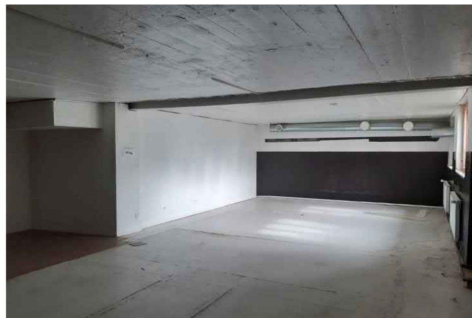
Kuva 42. Juuston suolausallas on purettu. Allas on ollut koko tilan pituinen. Tila sijaitsee radan varressa juustolasivessä, joka on osittain maanalla. Viimeisimpänä tilassa toiminut kuntosali. Tila on matala. Valoiseksi maalattua betonia on käytetty katossa ja lattiasa, myös seinät ovat joko valkoisia tai tummia. Jossain kohdin kuntosali on myös punatiilipintaista seinää.
