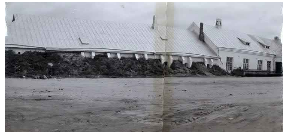
Kuva 49. Juustolasiiven maavallilla tuettu rakenne. (Limingan Osuusmeijerin kuva-arkisto)
