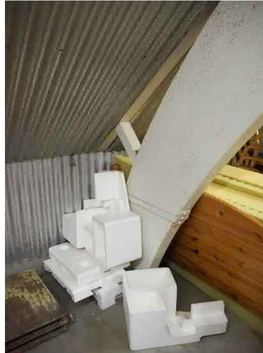
Kuva 64. Entisen maidonpakkaamon vesikaton kattorakenteena on alareunasta kaareutuvat liimapuupalkit.
