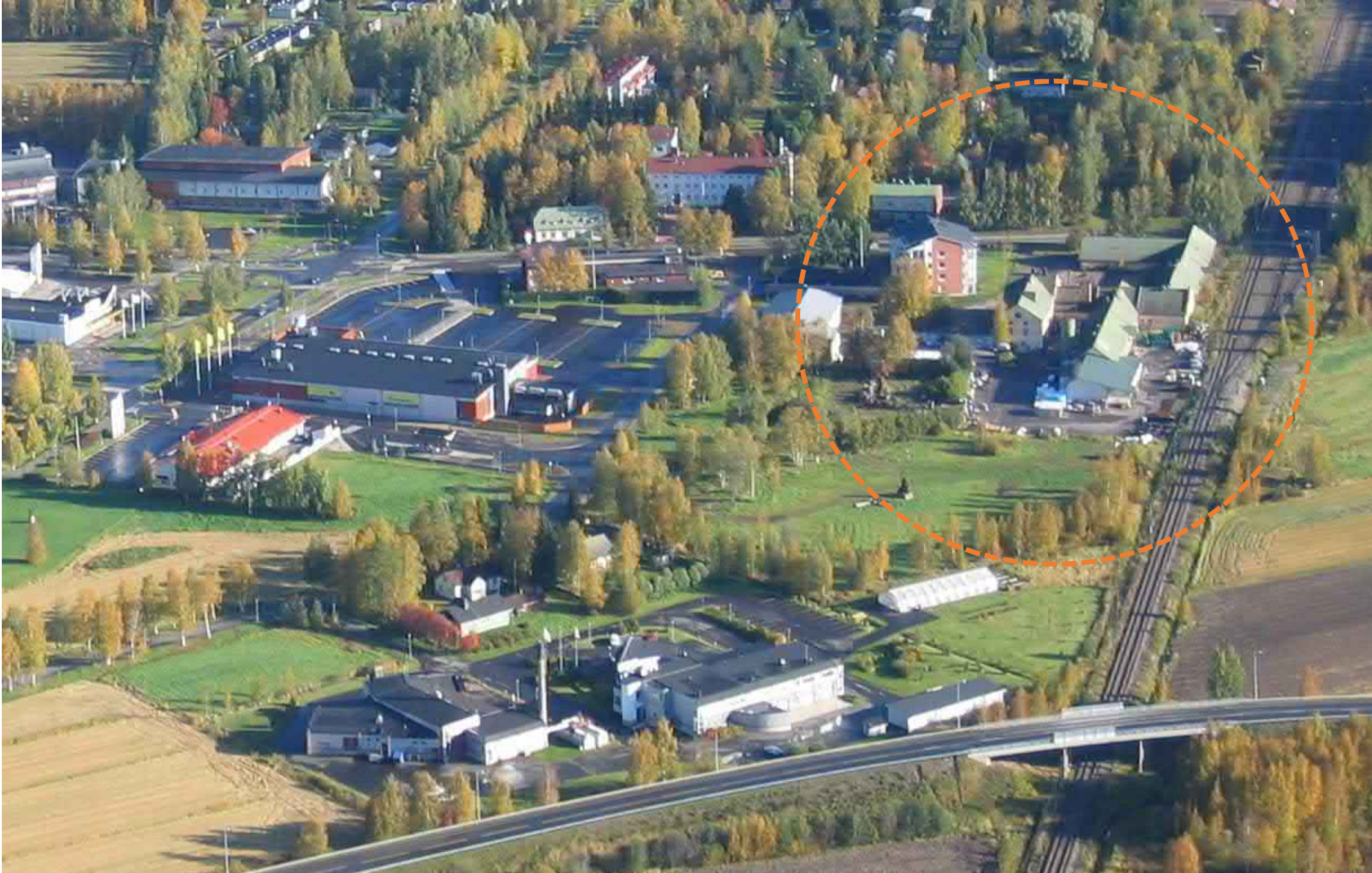
Kuva 34. Limingän keskusta pohjoiseen. Kuvassa näkyy meijeri ja sen lähiympäristö. Meijerikokonaisuus ja sen lähirakennukset ympäröity oranssilla katkoviivalla. (Pentti Kela, 2006)
