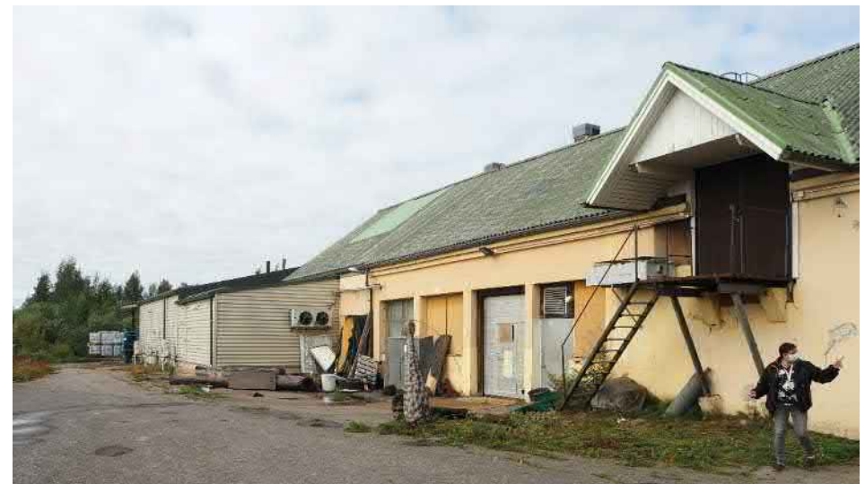
Kuva 44. Lounaispäädyn siipirakennusta on laajennettu ja muokattu useaan otteeseen.
