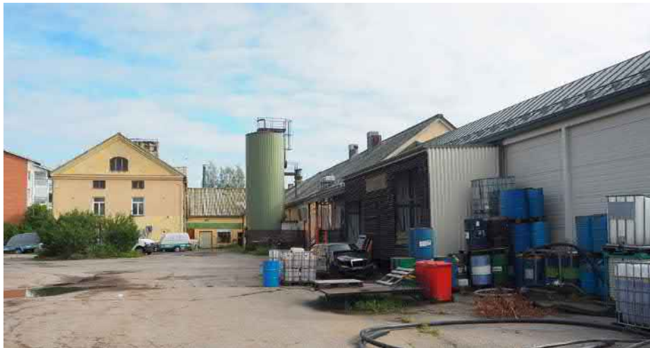
Kuva 38. Meijerin rakennuskokonaisuutta lounaasta kuvattuna. Oikealla näkyy vuoden 1997 laajennus, jonka edustalla on lastauslaituri-alue (elokuu 2021).
