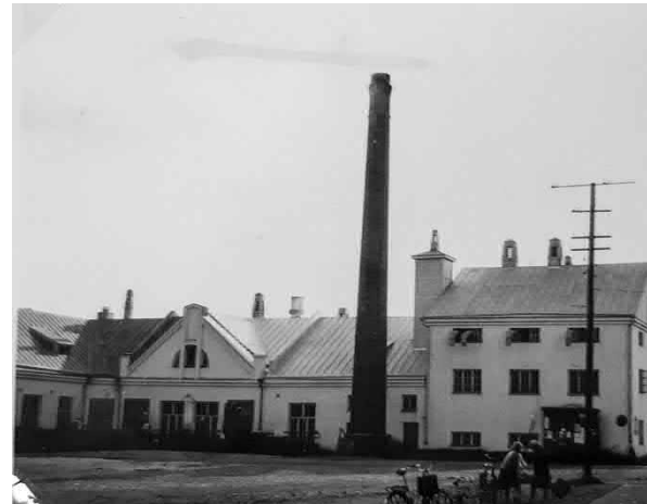
Kuva 67. Osuusmeijeri tulipalon ja korjauksen jälkeen. (Limingan Osuusmeijerin kuva-arkisto)
