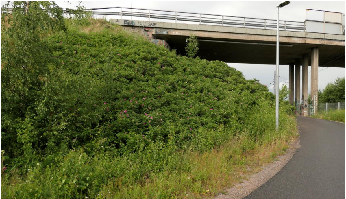
Kuva 15. Lumijoentien alikulun penkereellä on laaja kurturuusuesiintymä.
