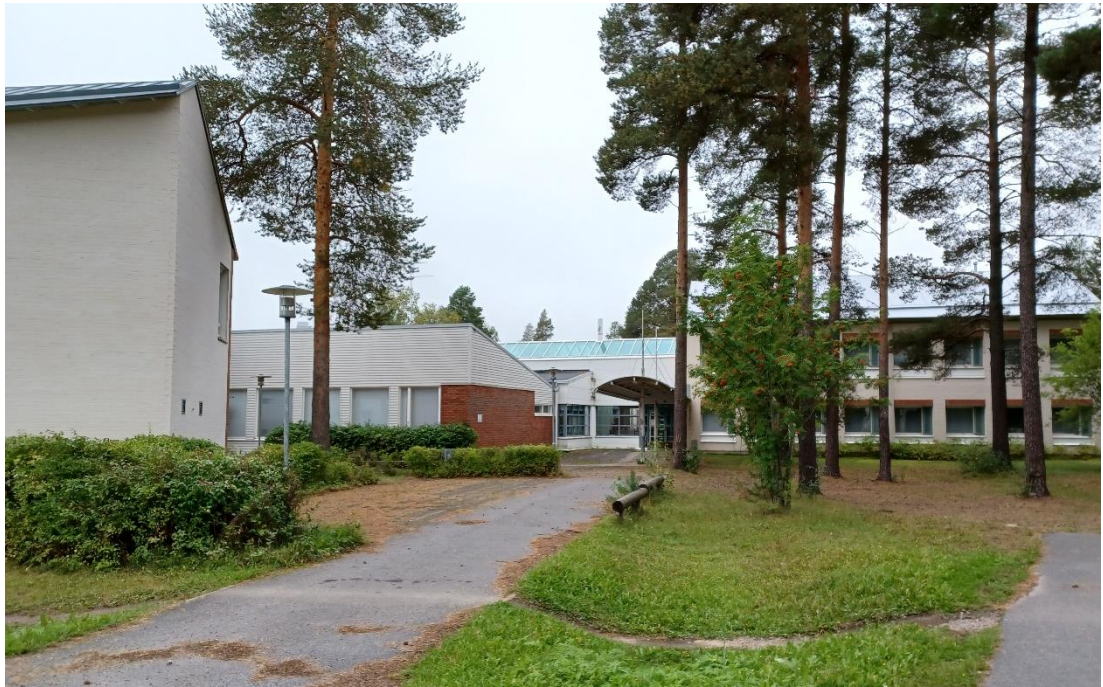
Kuva 14 Vesikari kuvattuna Sortavalantieltä. Kuvassa näkyy koulurakennuksen useita rakennusvaiheita.
