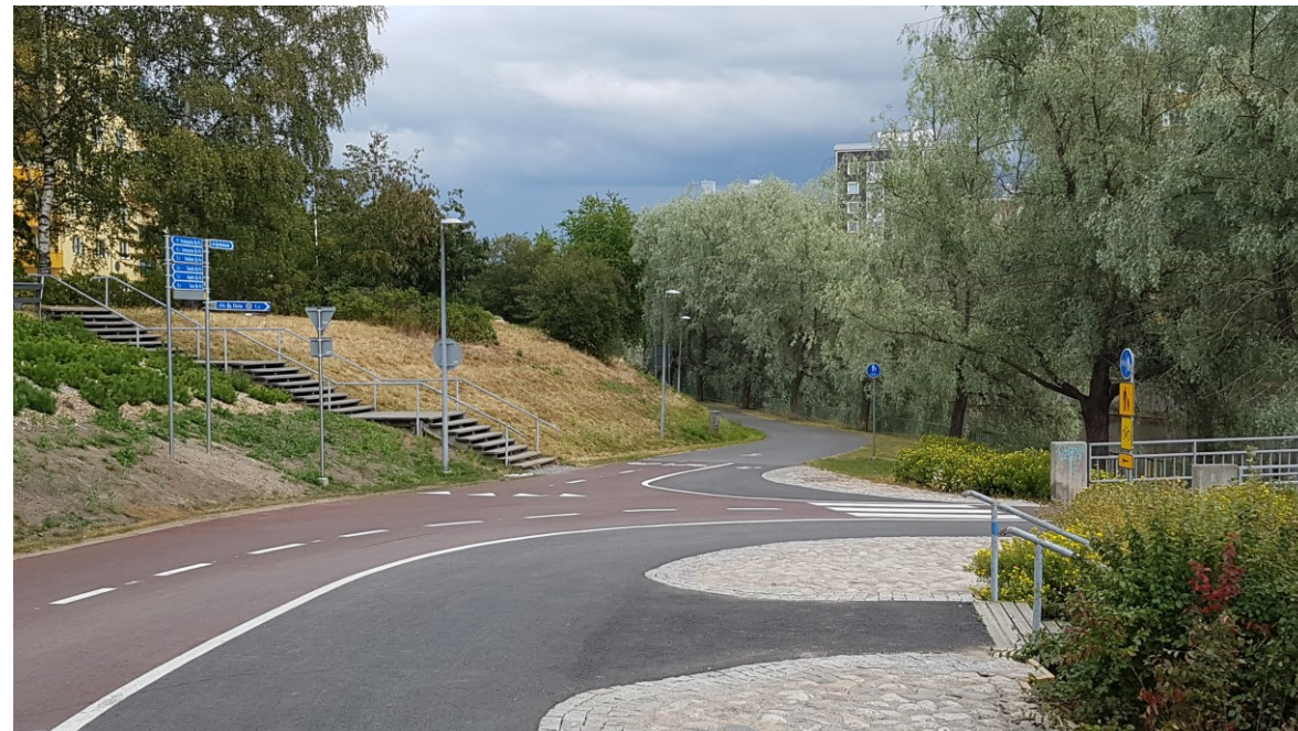
Pyöräliikenteen pääreitillä sivusuunnat väistävät ja reitit ovat viitoitettuja (valokuva Reijo Vaarala).
