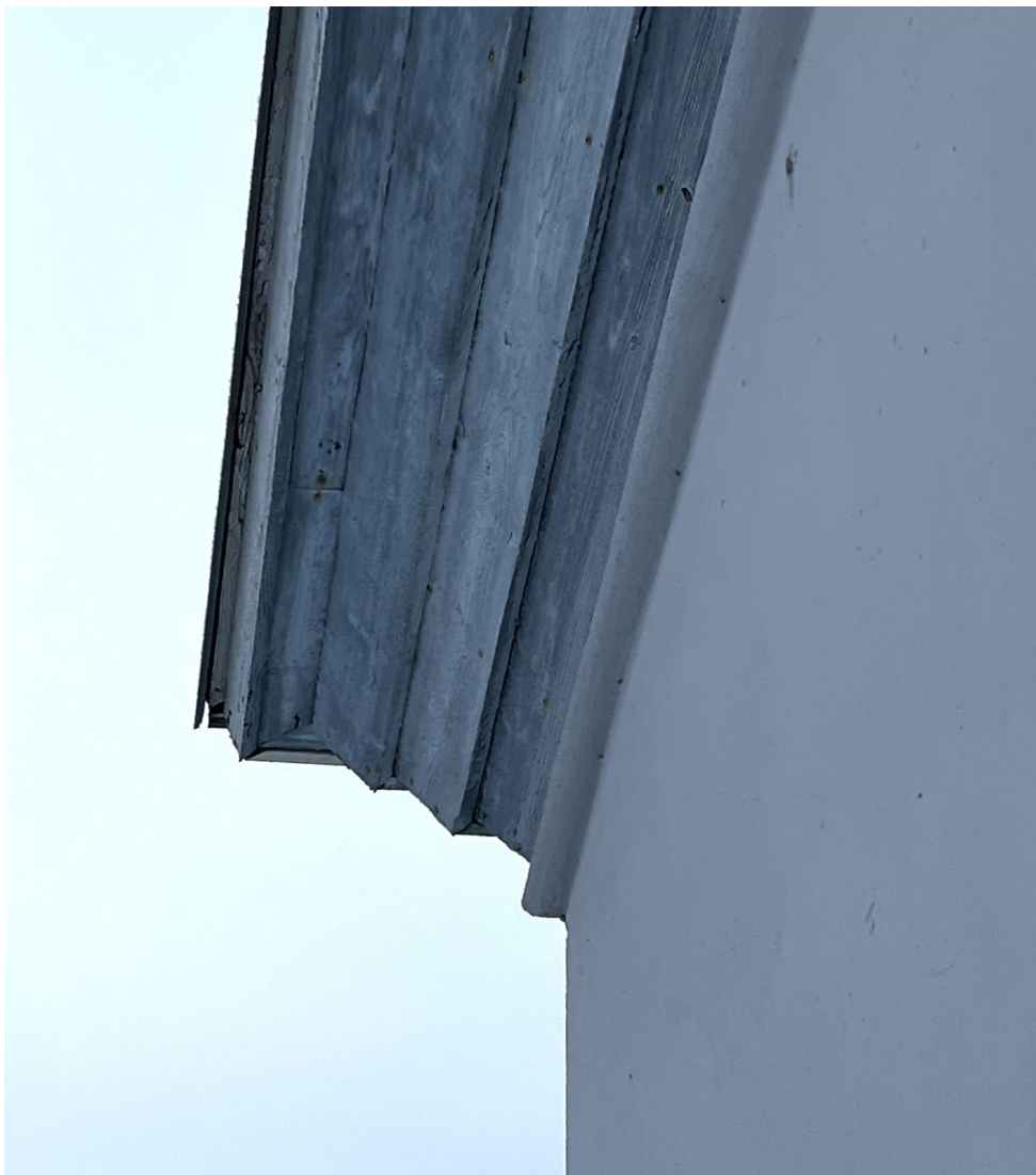
Julkisivun alkuperäisiä yksityiskohtia ovat muun muassa sokkelin muuratut koristelistat ja puiset porrastetut räystäslistat.
