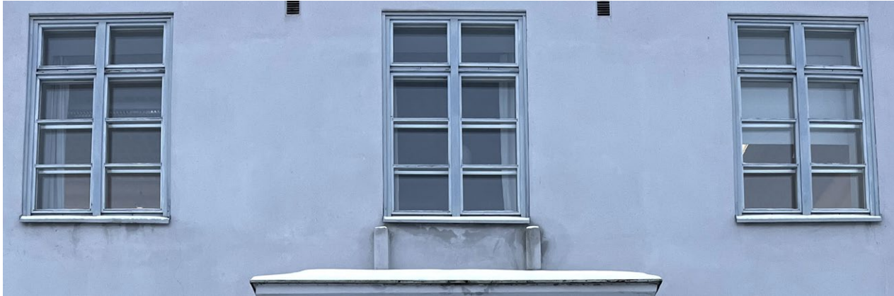
1990-luvulla uusittuihin ikkunoihin on palautettu alkuperäisen mallin mukainen puitejako. Samalla ikkunoiden sijoittelua on siirretty julkisivupinnassa syvemmälle ulkoseinärakenteen kosteusvaurioiden ehkäisemiseksi. Keskimmäisen ikkunan vanhasta koristelutoituksesta on jäljellä konsolit.
