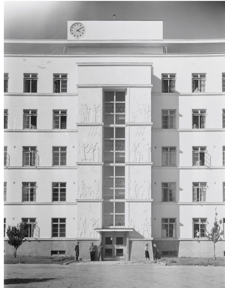
Jussi Paatelan suunnittelema Kinkomaan parantola (1930) edustaa hyvin 1920-luvun lopun arkkitehtuurin siirtymävaihetta klassismista funktionalismiin. Rakennuksen symmetrisesti sijoittuva ja horisontaalisesti liioiteltu, koristeellinen pääsisäänkäynti erottuu pelkistetyistä julkisivusta. Kuvassa näkyvä terveysikkunan tyyppi on sama, jota Paatela käytti Limingan emäntäkoulussa. (Museoviraston kuva-arkisto)
