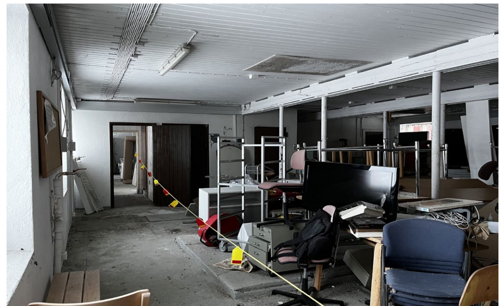
Navettarakennus kuvattuna sisältä selvityksen tekoaikaan: entinen kanala ja karjatila.
