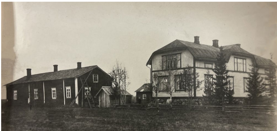
Kuva emäntäkoulun sijoituspaikaksi myydyistä Launosien tilasta 1920-luvulla ennen vanhojen rakennusten purkua. (Kansallisarkisto)
