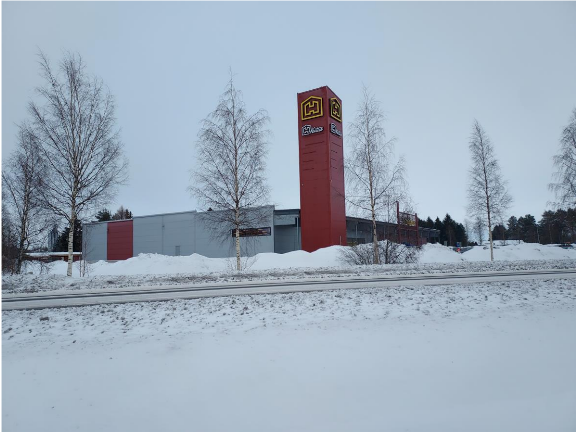
Kuva 15. HalpaHallin liikerakennus mainospyloneineen.
