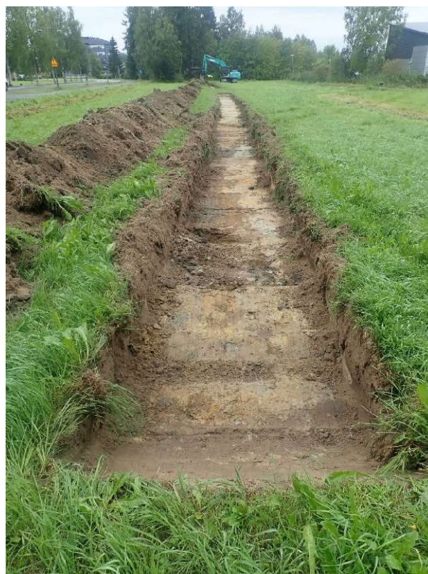
Kuva 14. Koeoja 8 itäpäältä kuvattuna. Etualalla kaivantoja ja ojia.
