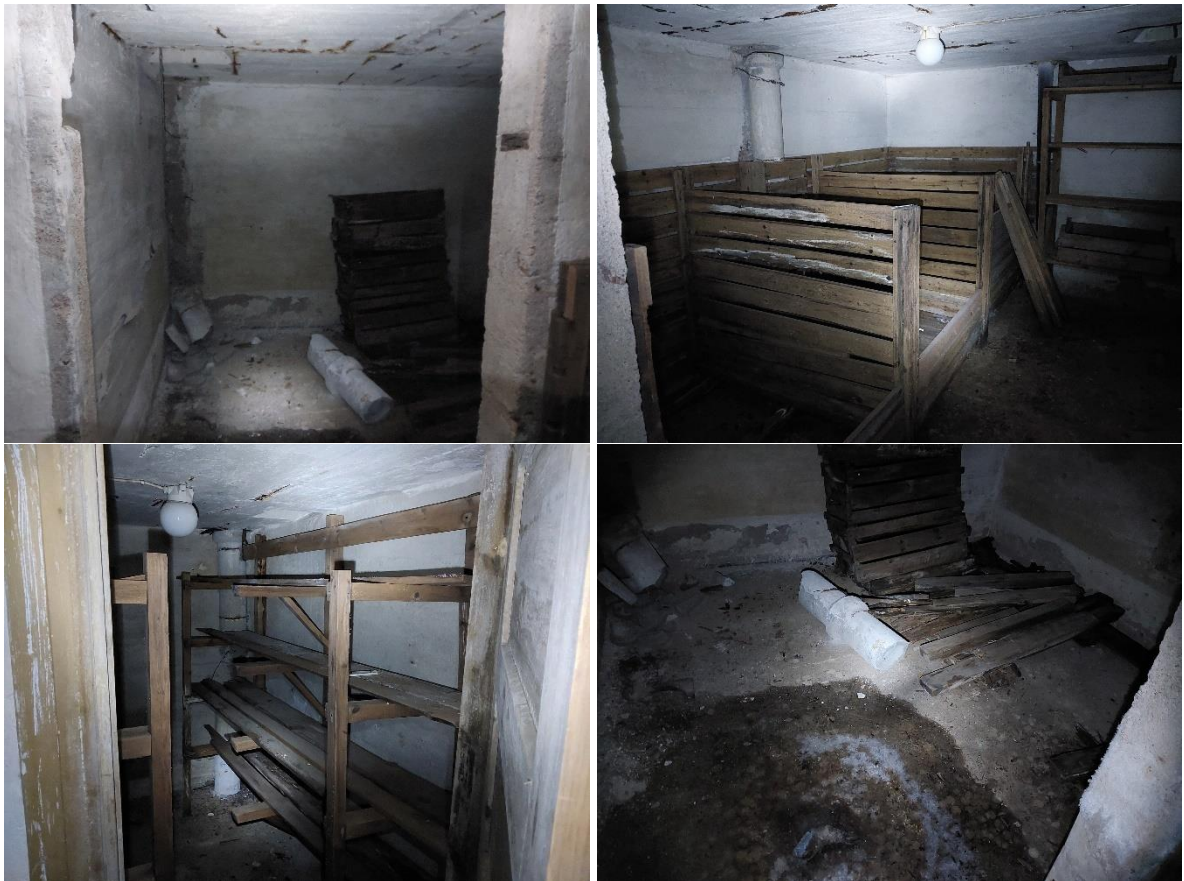
Kuva 2. Kellarin eteläinen puolisko, näkymiä sisältä.
