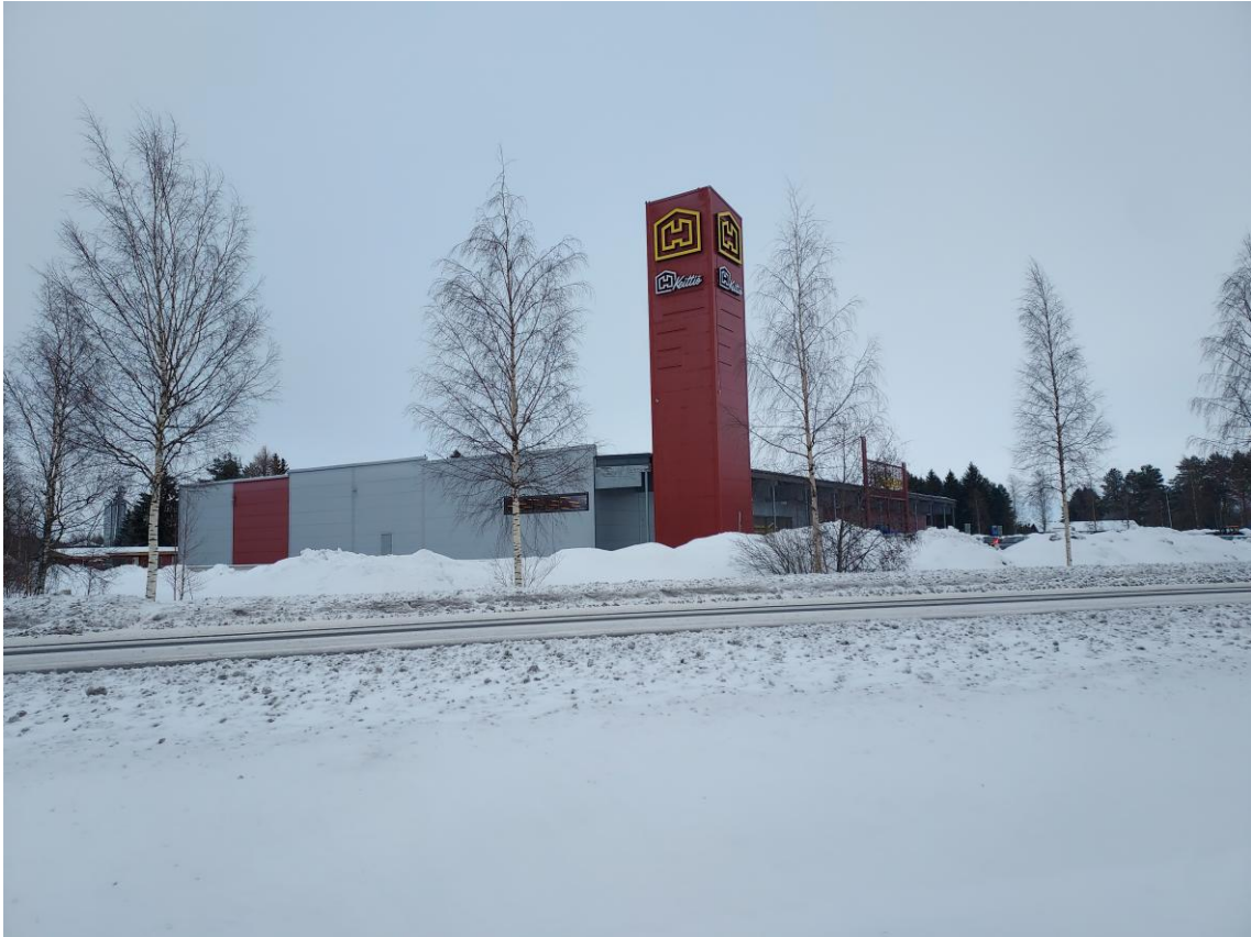
Kuva 15. HalpaHallin liikerakennus mainospyloneineen.
