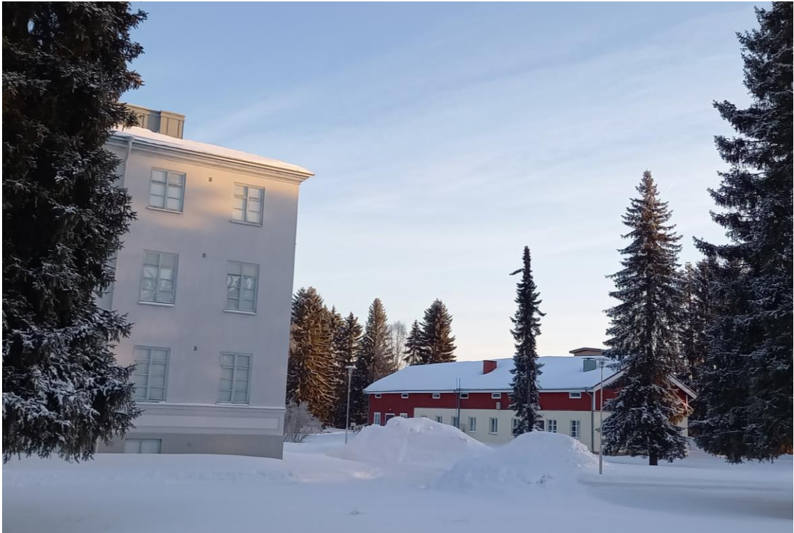
Kuva 38. Emäntäkoulun pihapiiri on komea esimerkki aikansa opetustoimintaa palvelevasta rakentamisesta.
