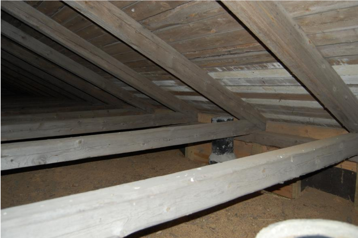
Kuva 16. Yläpohjan kattotuolit ja vesikatteen umpilaudoitusta
