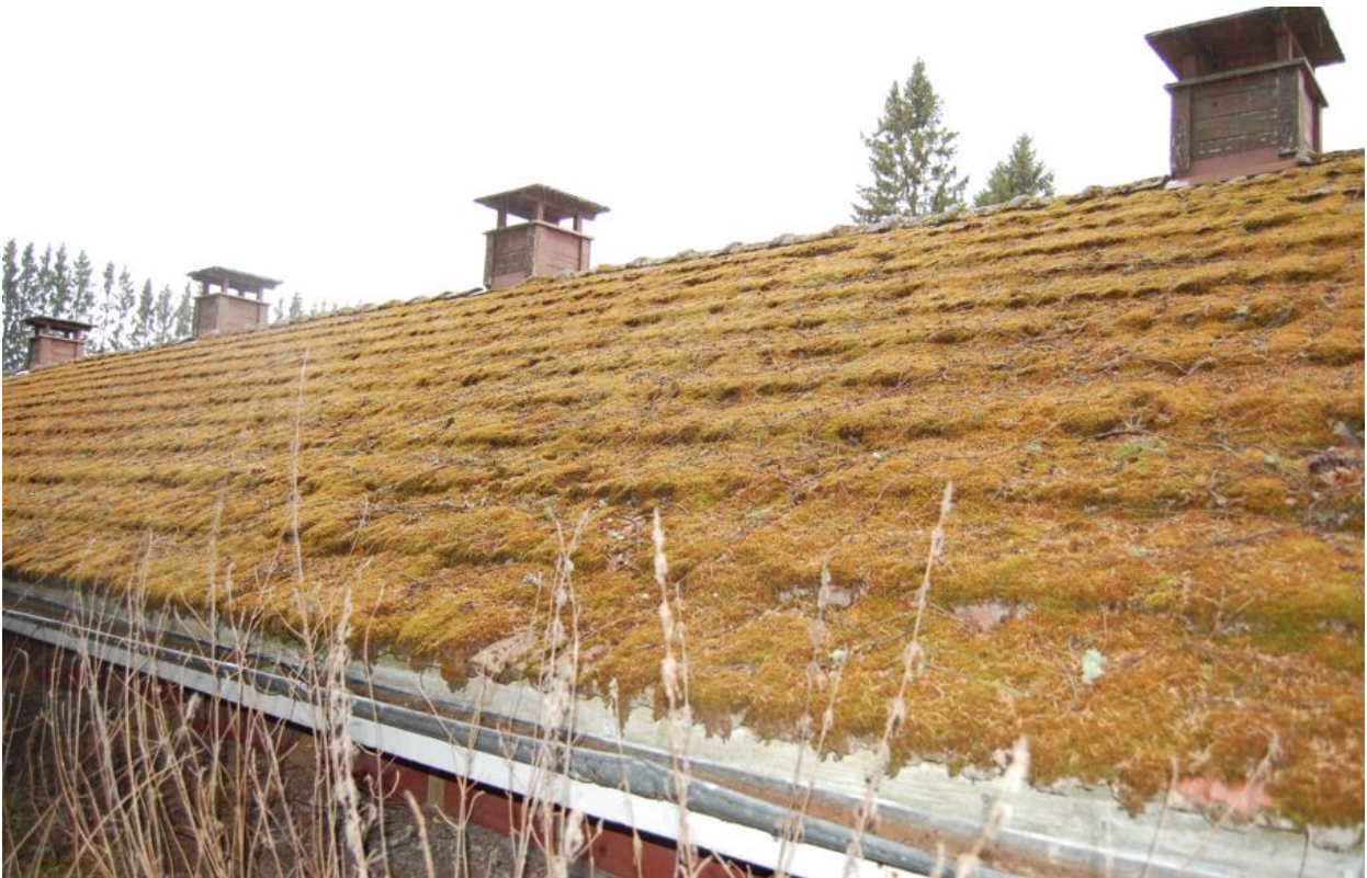
Kuva 18. Tiilikate on sammaleen peitossa.
