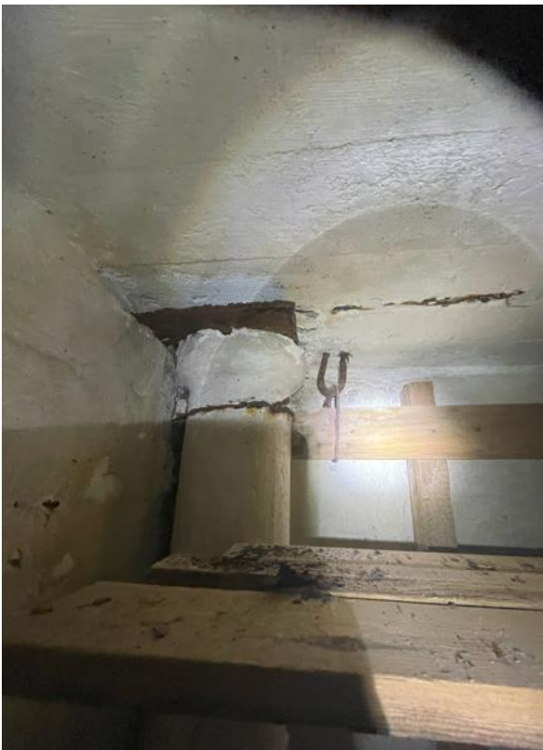
Kuva 23. Putki maakellarin huoneesta yläpohjaan. Kuva 24. Ilmaputki yläpohjassa
