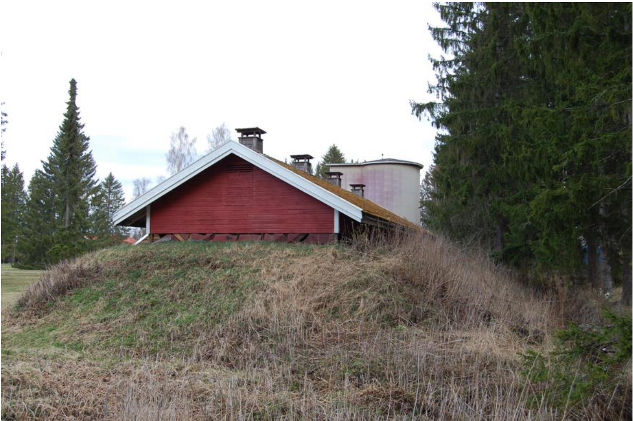
Kuva 3. Maakellarin takaosaa suojellun kuusiainan välittömässä läheisyydessä.
