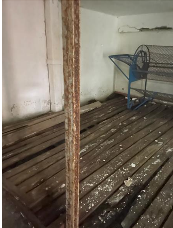
Kuva 34. Ruostunut teräspilari
