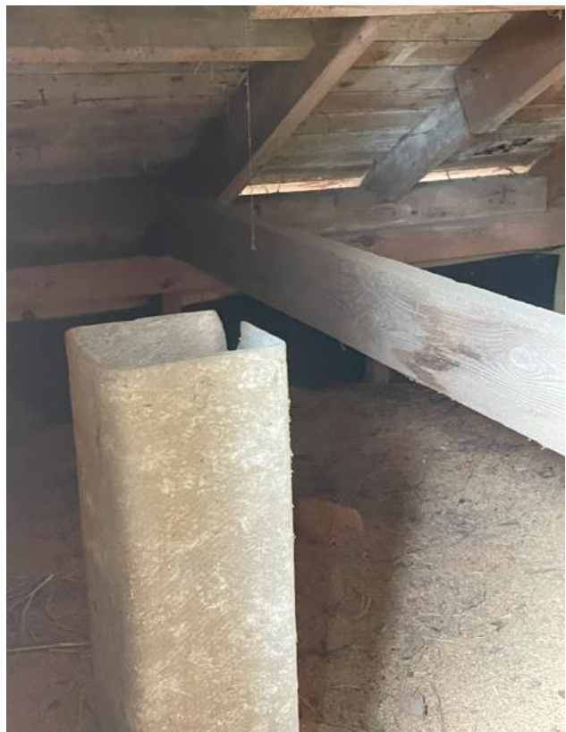
Kuva 23. Putki maakellarin huoneesta yläpohjaan. Kuva 24. Ilmaputki yläpohjassa
