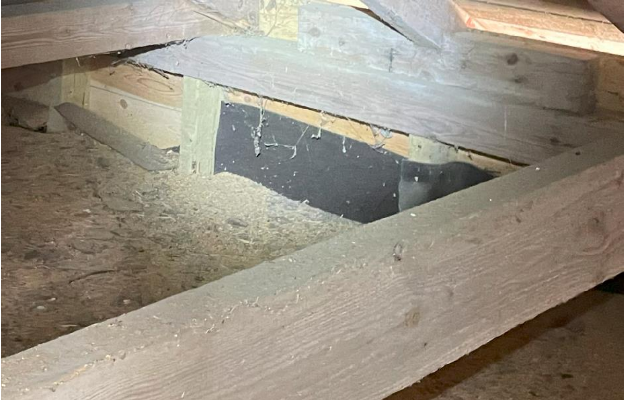
Kuva 7. Betoniseinä jatkuu yläpohjassa puurunkoisena. Puurunkoa korjattu kyllästetyllä puutavaralla.
