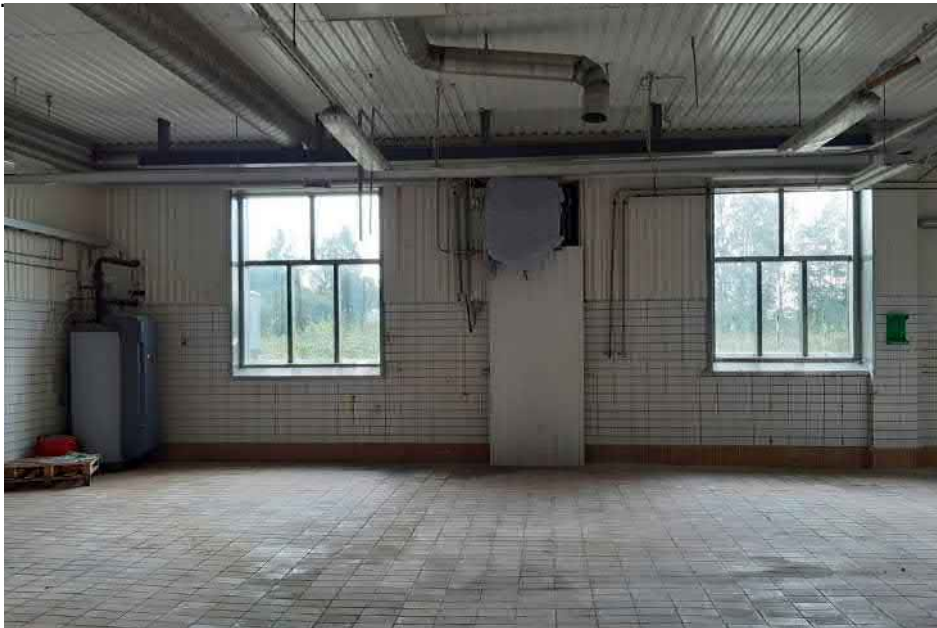
Kuva 41. Entinen juustonvalmistustila elokuussa 2021. Ikkunat on uusittu jossain vaiheessa tuotantotiloihin sopiviksi. Ne ovat todennäköisesti haponkestävää terästä. Tilan väritys on vaaleaa.
