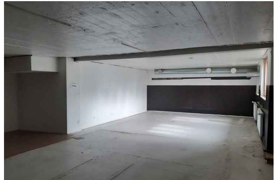
Kuva 42. Juuston suolausallas on purettu. Allas on ollut koko tilan pituinen. Tila sijaitsee radan varressa juustolasiivessä, joka on osittain maanalla. Viimeisimpänä tilassa toiminut kuntosali. Tila on matala. Valoiseksi maalattua betonia on käytetty katossa ja lattiassa, myös seinät ovat joko valkoisia tai tummia. Jossain kohdin kuntosali on myös punatiilipintaista seinää.
