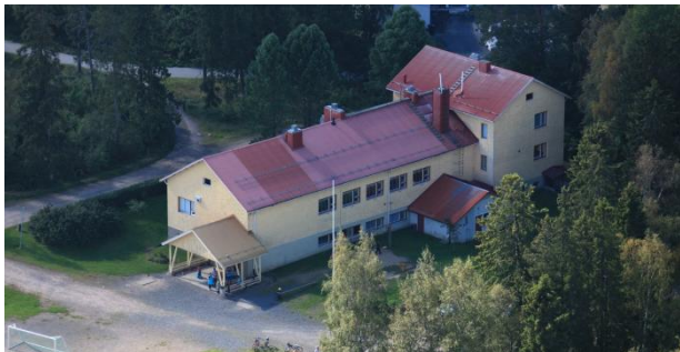
Kuva 72: Kuvaote (ilmakuva vuodelta 2016) Rantakylän koulun rakennushistoriaselvityksestä (Rantakylän koulu, Rakennushistoriaselvitys, Konsultointi Karhulat Oy, 4.9.2025).
